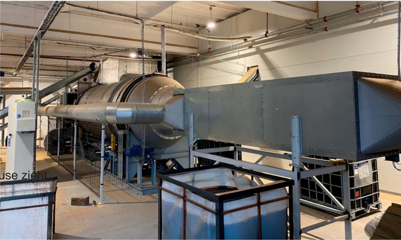
/ 2. Rekuperator, der 200 kW Wärme bei einer Temperatur von 170 °C zurückgewinnt
