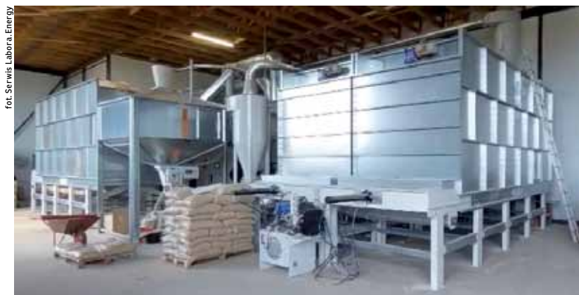
Linia do pelletowania własnych trocin z suszarnią Eco Air Dryer u producenta więzby dachowej.
